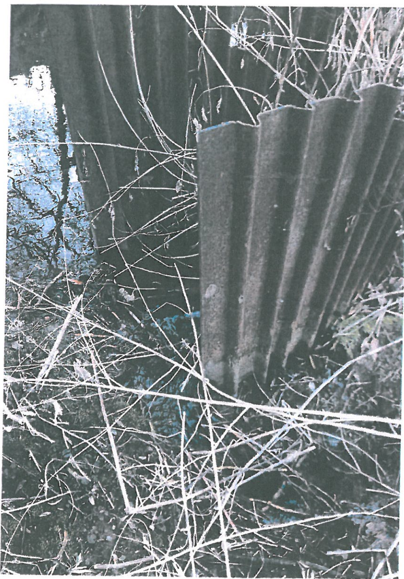
Obr. 2 Provizorní zabezpečení Union pažnicemi
